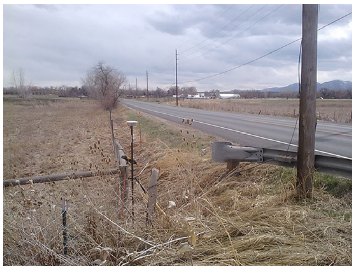
16 AV 1949 LOOKING SOUTH
